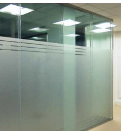
Vrijwel naadloze aansluiting van de glaspanelen met een voltransparante O-voeg.
